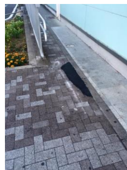
同 簡易修繕後 (10/28)
